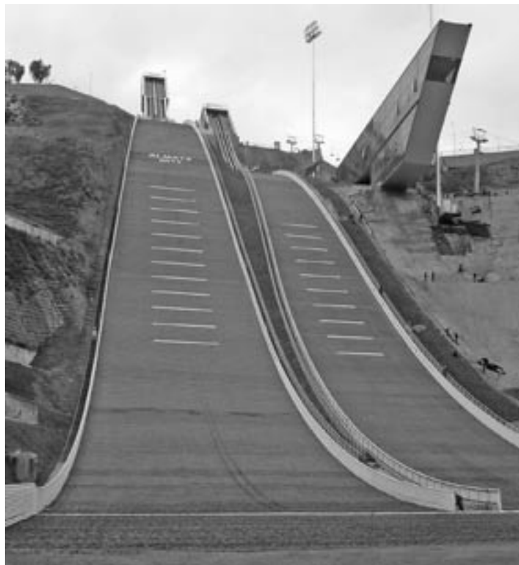
Das Prestigeprojekt für die 7. Asiatischen Winterspiele in Almaty wurde mit deutschem Know-how gebaut. Foto: Schertel Architektur
